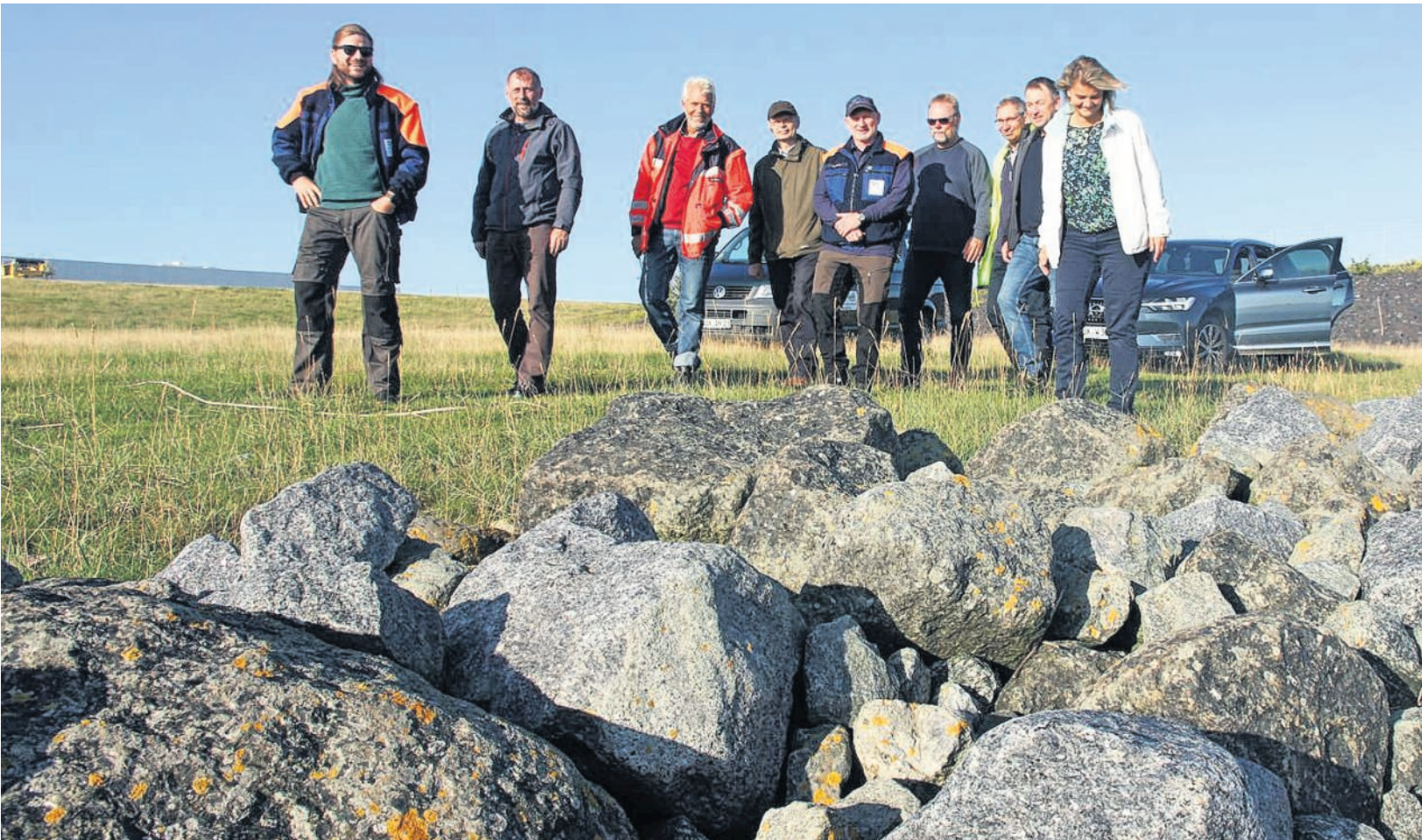
Die Deckwerksschau des Hadler Deichverbands begann am Dienstagmorgen an der Verbandsgrenze in Groden, wo sich das rückwärtige Deckwerk im Laufe der Jahr erhöht und stabilisiert hat. Dennoch soll der Wall aus Granitsteinen aus Uferschutzgründen erhöht werden. Foto: Sassen
